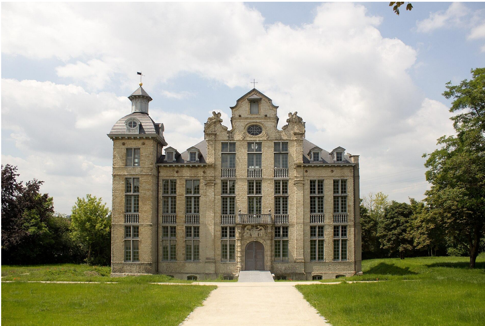
Kasteel Beaulieu in Machelen (zoals in de 19de eeuw verbouwd en recent gerestaureerd) gebouwd in opdracht van Graaf Lamoraal II von Thurn & Taxis tussen 1653 en 1656 (eind 17de eeuw al verkocht aan Jean-Paul Bombarda, stichter van de Muntschouwburg) Veel verschillende eigenaars sindsdien, sinds 1980 eigendom van het Vlaams Gewest
